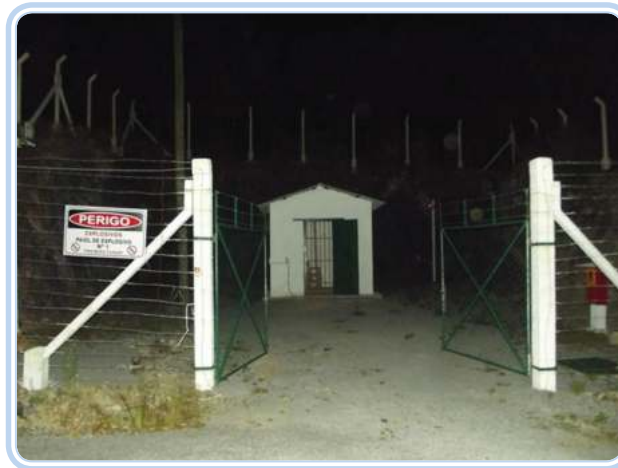
Figura 2.5: Depósito de explosivo
